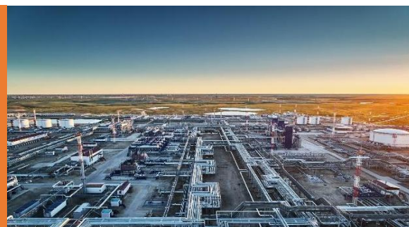
Обустройство месторождения Восточно-Мессояхское
