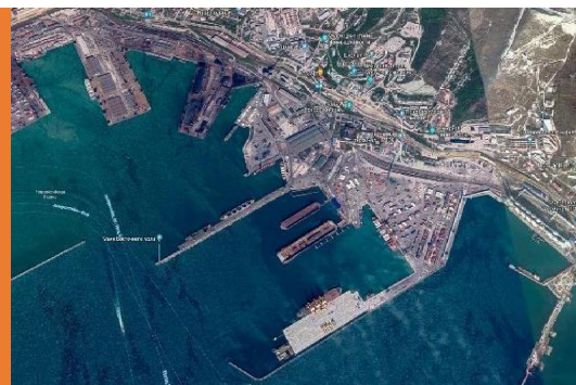
Реконструкция 13 причала г. Новороссийск
